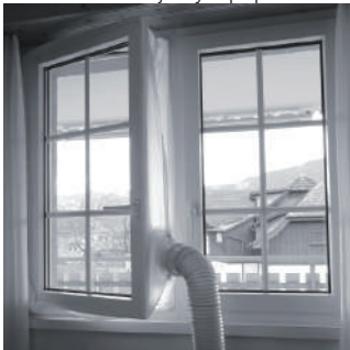
INSTALACE VÝFUKOVÉHO POTRUBÍ
