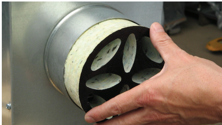
Druk de demper in de opening
