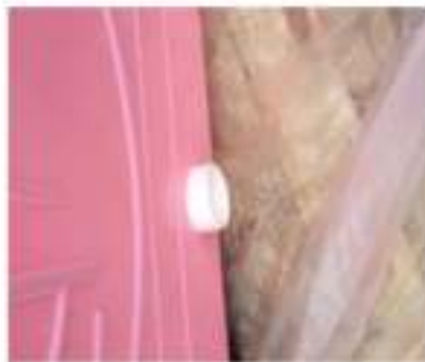
3. Aan de buitenkant steekt de plug door de badwand
