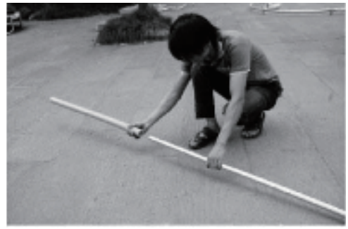
Enfilez un manchon en mousse sur un tube.
