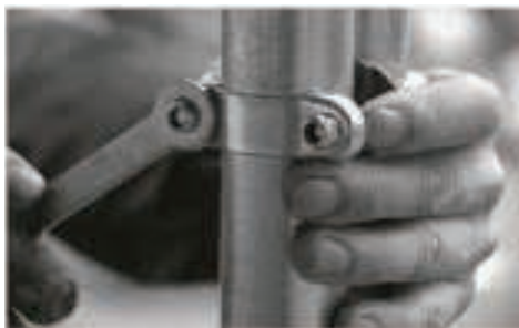
7. Collegare il secondo morsetto alla parte superiore del pilastro.
