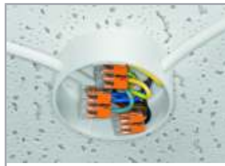
Verdeling van verlichtingssystemen in centraaldozen
