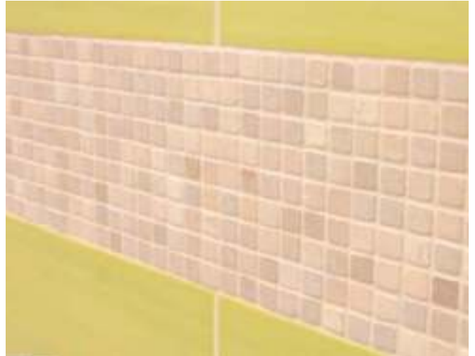
10 Oppervlakken van hard gebakken tegels en natuursteenmozaïek gevoegd met Sopro DF 10®.
