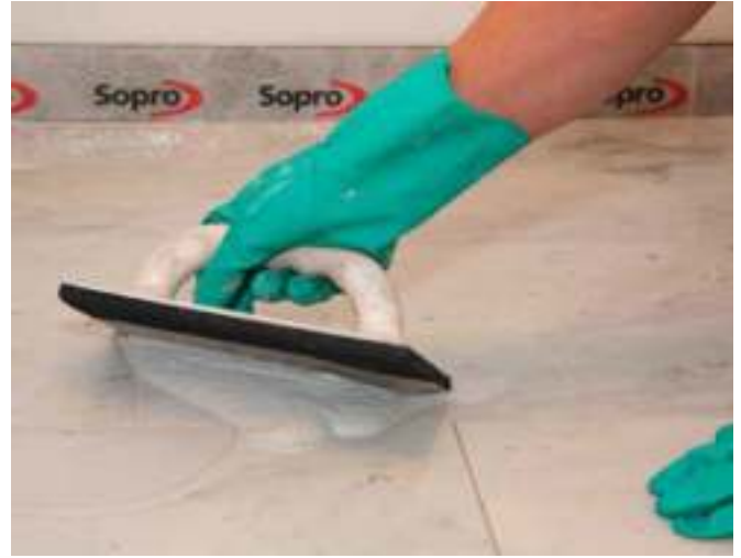
8 Het voegen van natuursteen gevoelig voor verkleuring met Sopro DF 10®.
