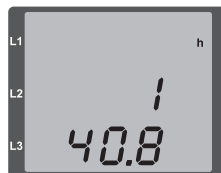
Abb. Messwertanzeige Betriebsstundenzähler
