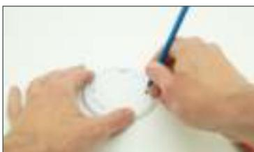
Pour ce faire, placez le support contre le plafond et marquez l'emplacement des trous à forer au moyen d'un crayon. Forez les trous et, si nécessaire, utilisez les chevilles
