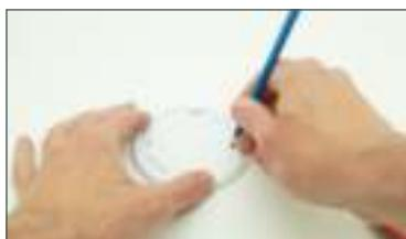
Markeer met een potlood de boorgaten via de montagebeugel op uw plafond. Boor de gaten en gebruik, indien nodig, de pluggen.
