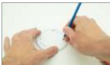
Zeichnen Sie die Bohrlöcher mit einem Bleistift durch die Halterung an der Decke an. Bohren Sie die Löcher und verwenden Sie, falls erforderlich, die Dübel.
