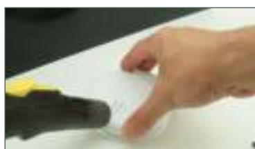
Pulire il rilevatore regolarmente (una volta al mese) in base alla posizione. Pulire con l'aspirapolvere il rilevatore nei pressi della camera e sui lati. È possibile usare la spazzola morbida dell'aspirapolvere.
