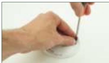
Schroef de bodemplaat vast aan het plafond. Verzeker u er van dat de bodemplaat strak tegen het plafond zit zodat er geen luchtcirculatie boven de rookmelder kan plaatsvinden, die rookdetectie kan verhinderen. Indien nodig deze opening dichten met kit.
