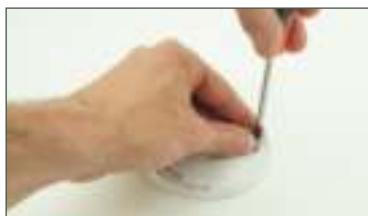
Bohren Sie die Löcher und verwenden Sie, falls erforderlich, die Dübel. Schrauben Sie die Bodenplatte an der Decke fest. Stellen Sie sicher, dass die Bodenplatte fest an der Decke anliegt, damit keine Luftzirkulation über dem Rauchmelder auftreten kann, die die Rauchdetektion verhindern kann. Falls erforderlich, dichten Sie diese Öffnung mit einem Dichtungsmittel ab.
