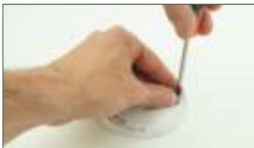
Vissez ensuite le support au plafond et fixez-y la plaque arrière du boîtier. Veillez à ce que la plaque soit fixée le plus près possible du plafond, de manière à ce qu'aucune circulation d'air ne soit possible au-dessus de l'appareil - cela pourrait entraver la détection de fumée. Si nécessaire, bouchez l'espace à l'aide de mastic.
