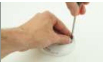
Avvitare saldamente la base sul soffitto. Accertarsi che la base aderisca bene al soffitto, in modo che non possa circolare aria al di sopra del rilevatore, impedendo così il rilevamento del fumo. Se necessario, sigillare lo spazio con del mastice.
