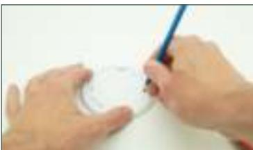
Usare una matita per segnare i punti in cui realizzare i fori per la staffa di montaggio sul soffitto. Creare i fori e inserire i tasselli, se necessario.
