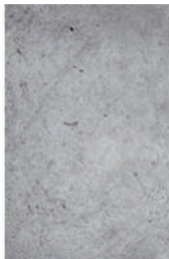
Mur de ciment
