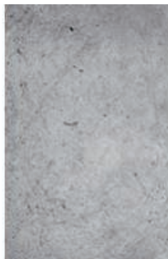
Muro di cemento
