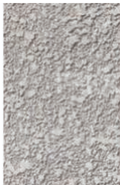
Mur de plâtre
