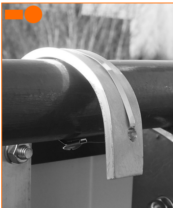
Beugel borging aan balkonreling bovenaan
