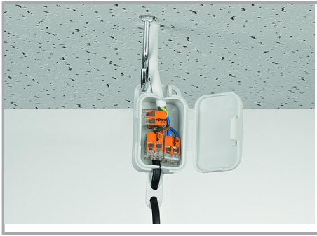
Aansluiting van pendelarmaturen in verlaagde plafonds
