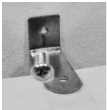
radiatorul la locul său și înșurubați conform imaginii alăturate. Acum radiatorul este fixat la locul lui.
