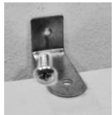
Uistite sa, či je teleso na stene pevne zavesené, ak je to potrebné, dotiahnite skrutky do hmoždiniak pevnejšie.
