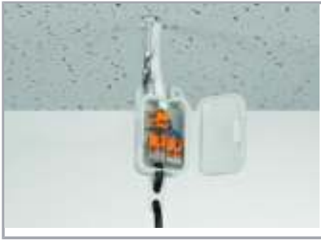
Aansluiting van pendelarmaturen in verlaagde plafonds
