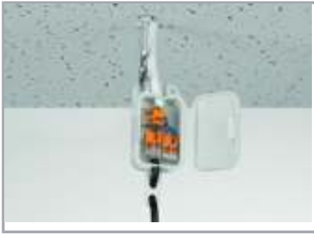
Aansluiting van pendelarmaturen in verlaagde plafonds
