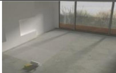
Maak de ondergrond schoon en egaal, daar waar de folie wordt geplaatst. Het is verplicht om isolatie te plaatsen onder de vloerverwarmingsfolie. Quality Heating heeft diverse isolatie mogelijkheden. Ga naar de webshop of neem contact op met de klantenservice. Heeft u een vochtige ondervloer, gebruik dan de FastHeat floor primer als voorstrikmiddel.
