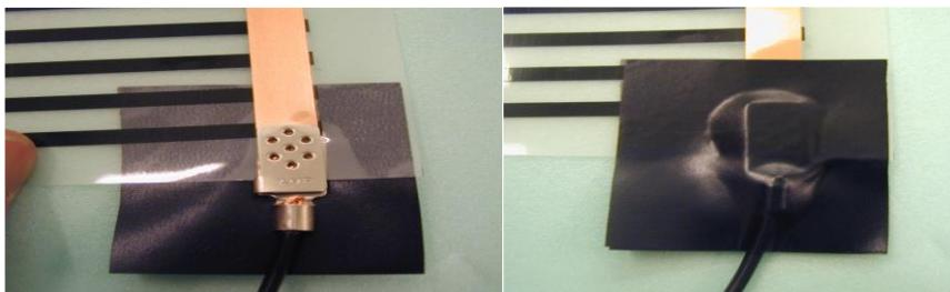
**Na de installatie. LET OP:** isoleer de krimpconnectoren altijd. Knip 2 stukjes isolatietape en plak deze aan beide zijdes over de krimpconnectoren. De tape moet ruim over de uiteinde van de krimpconnector bevestigd worden, minimaal 5 mm. Ook het uiteinde van de vloerverwarmingsfolie dient te worden geïsoleerd met isolatie tape.
