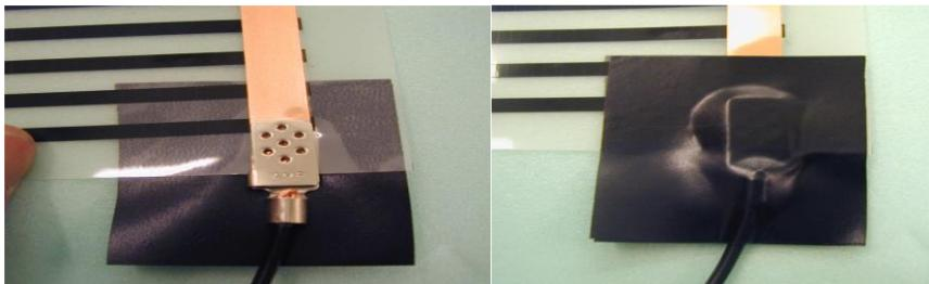
**Nach der Installation HINWEIS:** Isolieren Sie immer die Crimpverbinder. Schneiden Sie 2 Stück Isolierband ab und kleben Sie sie auf beiden Seiten über die Crimpverbinder. Das Isolierband muss mindestens 5 mm über dem Ende des Crimpverbinder angebracht werden. Außerdem muss das Ende der Fußbodenheizungsfolie mit Isolierband isoliert werden.
