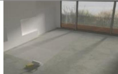
Reinigen und glätten Sie die Oberfläche, auf der die Folie liegen soll. Es ist zwingend erforderlich, eine Dämmung unter der Fußbodenheizungsfolie anzubringen. Quality Heating bietet verschiedene Dämmungsmöglichkeiten. Gehen Sie zum Webshop oder wenden Sie sich an unseren Kundendienst. Wenn Sie einen feuchten Untergrund haben, verwenden Sie FastHeat-Primer als Grundierung.
