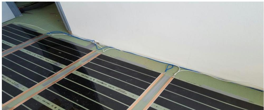
Machen Sie an der Stelle, an der der Thermostat über den Boden montiert wird, zwei Slits in der Wand. Die Anschlusskabel der Fußbodenheizungsfolie verlaufen durch den einen Schlauch und der „Sensor, Fußbodenfühler“ durch den anderen.
