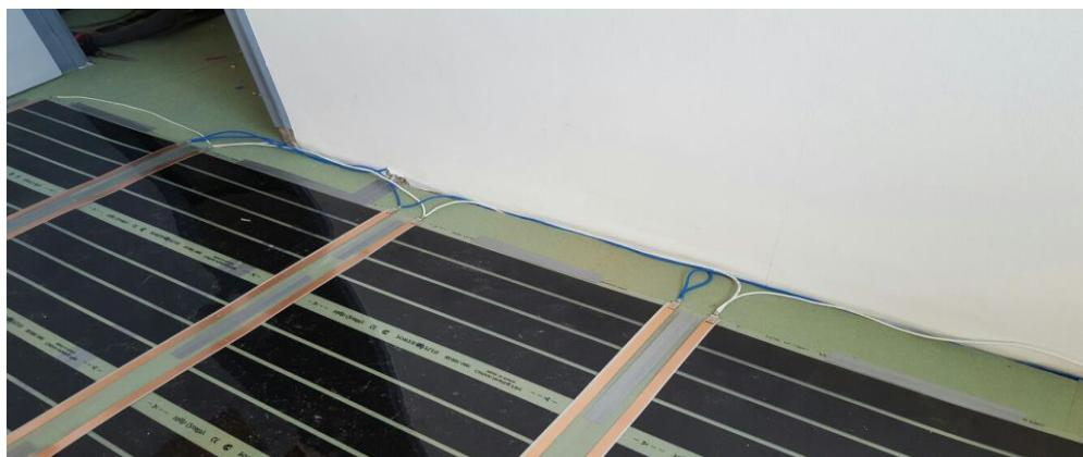
Maak twee sleuven in de muur vanaf het punt waar de thermostaat wordt gemonteerd naar de vloer. Door de ene buis lopen de aansluitdraden van de vloerverwarmingsfolie en door de andere buis loopt de 'voeler, vloersensor'.
