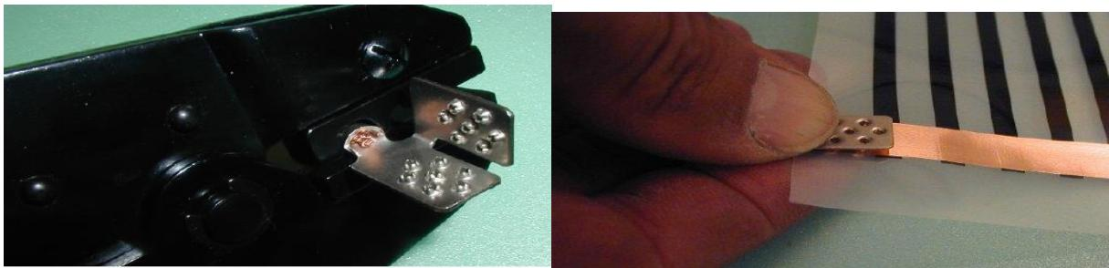
Als de complete vloeroppervlakte belegd is met de Quality Heating vloerverwarmingsfolie, dan kunnen de voedingsdraden worden aangesloten. Klem de krimpconnector vast d.m.v. de drukverdeeltang/krimp tang (foto boven). Let op: bij een enkele voedingsdraad (1e connectie) altijd de kerndraad dubbelvouwen! Knijp altijd aan beide zijden van de connector aan de bedrading vast. Plaats vervolgens de krimpconnector over de koperen geleider op de verwarmingsfolie. Knijp de druk verdeeltang goed dicht.
