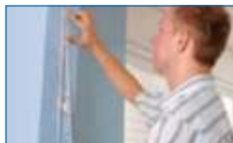
Metten van de deuropening (breedte en hoogte)
