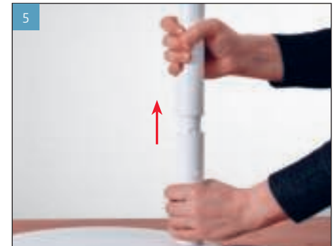
5 Eemaldage tugeva tõmbega kõik ühendustükid.
