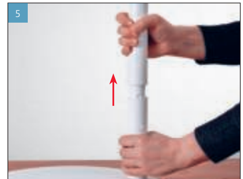
5 Odpojte všetky konektory pevným ťahaním.
