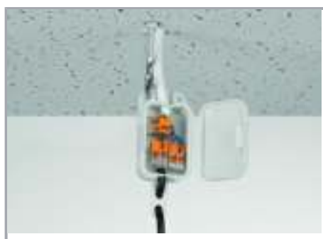
Aansluiting van pendelarmaturen in verlaagde plafonds
