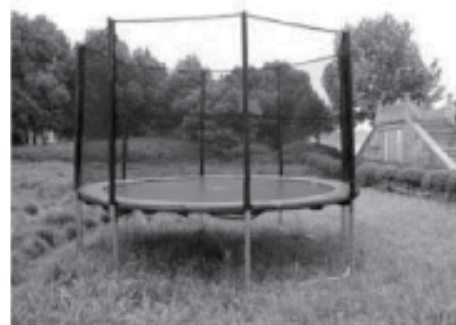
11. Dopo aver completato tutti i lavori, il trampolino con rete di sicurezza è pronto per l'uso.
